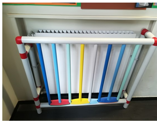
Figura 8.7 - Particolare dei radiatori esistenti
