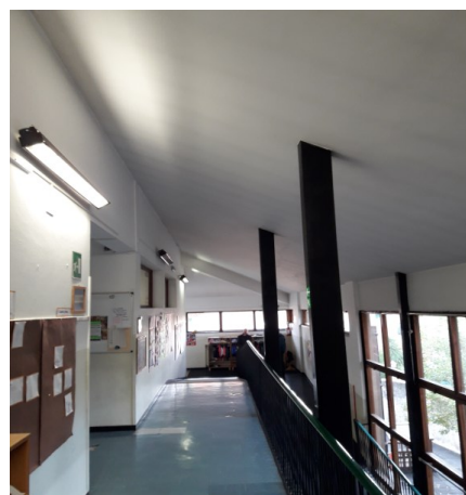
Figura 4.2 - Particolare della struttura in acciaio della passerella e dei solai disperdenti superiori in latero-cemento
