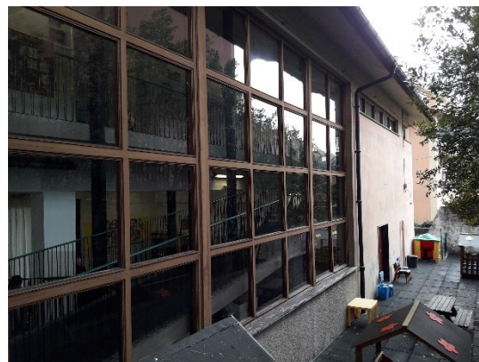
Figura 1.1 - Vista della facciata esposta ad ovest
