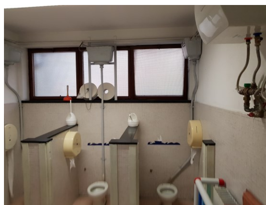
Figura 8.5 - Particolare dei serramenti esistenti
