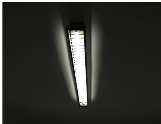
Figura 4.10 - Particolare dei corpi illuminanti ubicati nei locali dell'edificio
